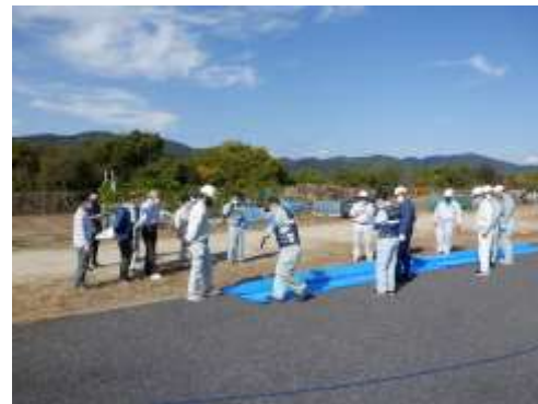
改良積み土のう工法
