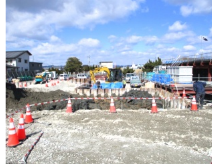
着々と進むポンプ場の工事現場
