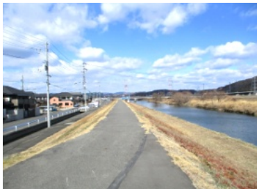
犬の糞の放置が多い笹ヶ瀬川堤防
