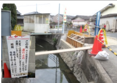
工事中前の石橋 3月中には新しい橋が完成
