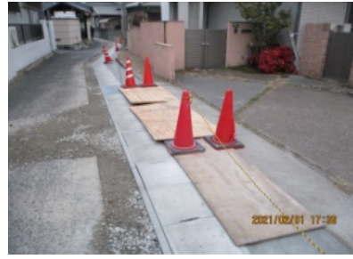
工事中の排水路
