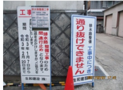
排水路の工事看板
