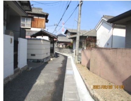
工事が完了した排水路
