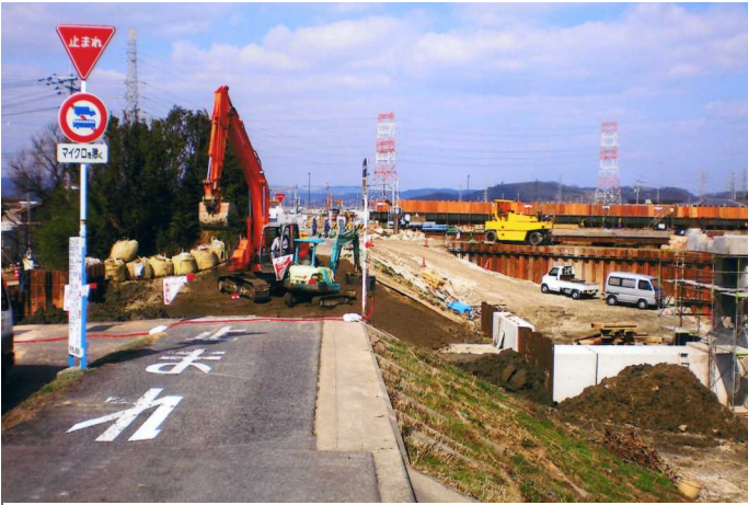
急ピッチで進む尾上樋門工事とJR吉備線付け替え工事
