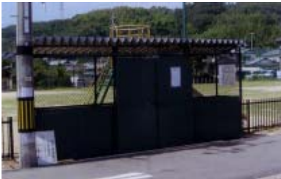
完成したあかね町のごみステーション
