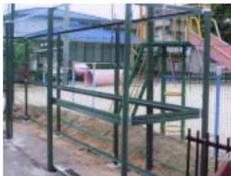
改修工事が始まったごみステーション
