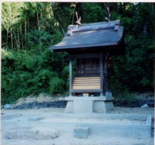
拝殿の基礎工事も終わり、建前(8月8日(木))を待つばかりになっているお宮の拝殿建設
