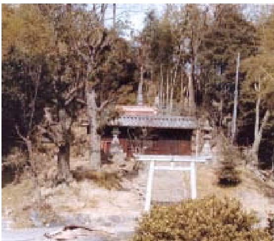
間もなくお宮客殿の建て替え工事が始まります 10月には完成した客殿で秋まつりを予定しています
