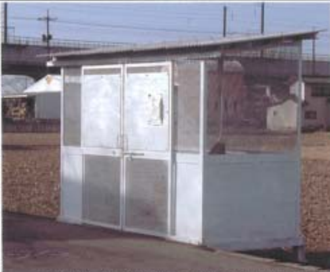
不適切排出(不分別や期日外の持ち込み)が目立った ゴミステーションも改修工事をしてスッキリしました
