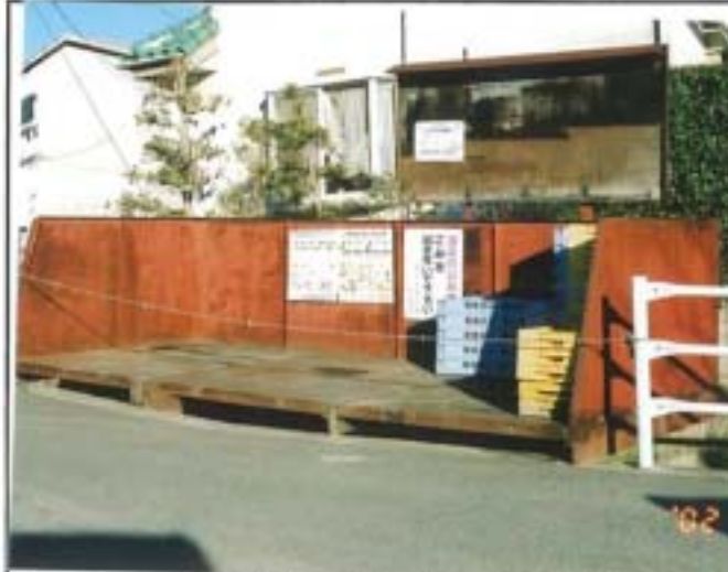
掲示板の張り替えや全体の改修、床面の修理、塗装の必要、狭路等早急に修理の必要なステーションが数多くありました
