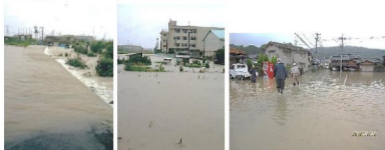
○小学校の東、橋手堤からの越水と小学校付近の浸水 ○尾上公会堂前の浸水
