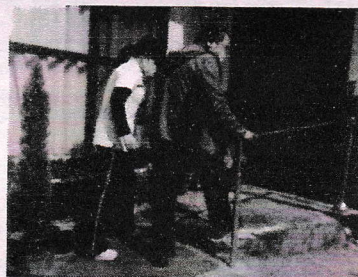
手すりの設置後、動作を確認している様子
