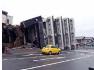
写真8 液状化によるビル倒壊
