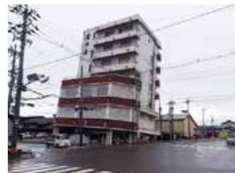
写真9 液状化によるビルの沈下
