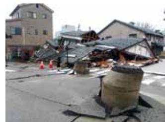
写真7 液状化によるマンホールの浮き上り
