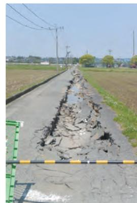
写真-3 熊本地震時の道路陥没
