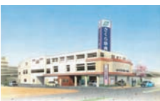
岡山駅前ホール
