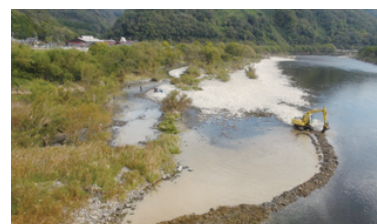
重機で分流の流れを堰く
