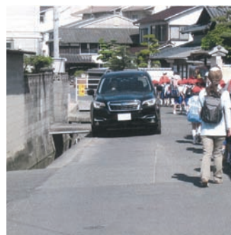
蓋掛け予定の用水路
