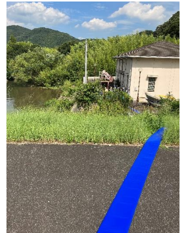
向こうに見える建物が大原排水機場 (旭川の堤防より撮影)
