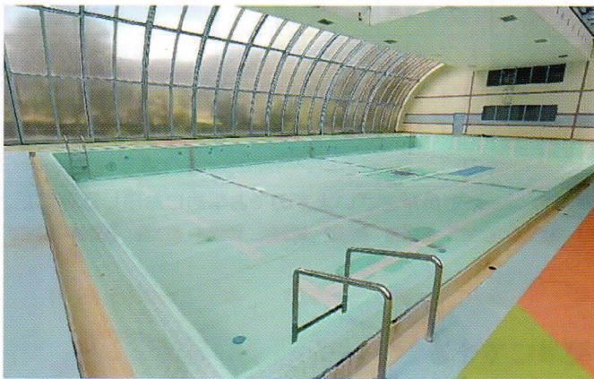
老朽化により改修予定の温水プール
