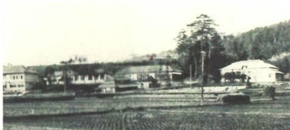
昭和27年 平津小学校に御津郡平津村立平津幼稚園開設
