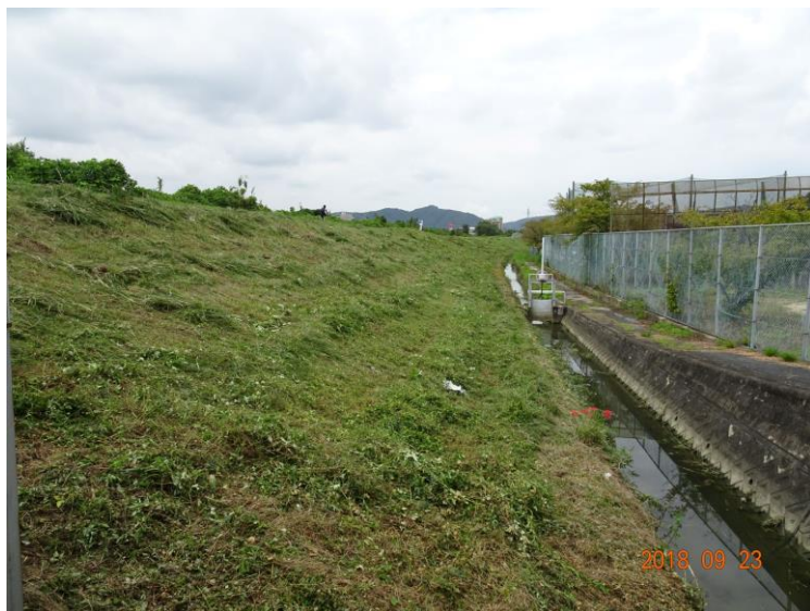
作業後（平成30年9月30日撮影）
