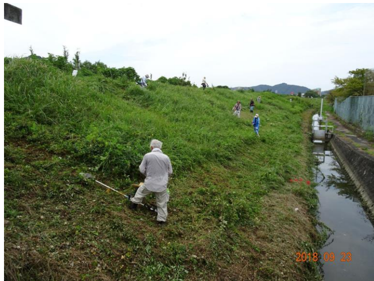
作業中（平成30年9月30日撮影）
