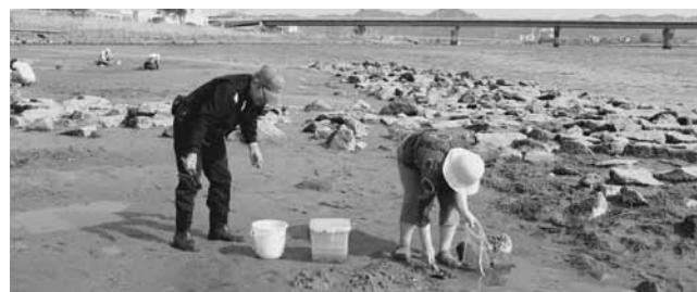
平井地区の旭川に見られるT字形の石組み。「何だ?」と首を傾げる人も多いでしょうが、実はこれ、全国でも珍しい歴史的遺構。昔から平井では「沈床」と呼ばれていますが、専門的には「ケレッブ水制」といわれ、川の流れを制御して土砂の沈殿を防ぎ、船の航路を確保する構造物。国内では旭川以外に木曽川(岐阜・愛知)などごく一部にしか見ら
