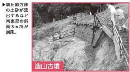
▶墳丘前部の土砂が流出するなど南東部の斜面3カ所が崩落。
