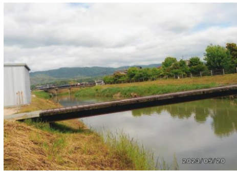
手前が「下土田下橋」奥が「共栄橋」
