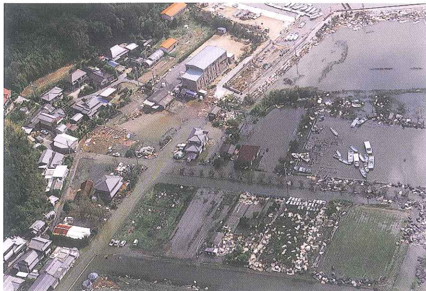
台風16号による被害の様子(小串米崎)
