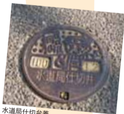
水道局仕切弁蓋
