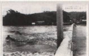
相生橋崩壊の現場(その2)
