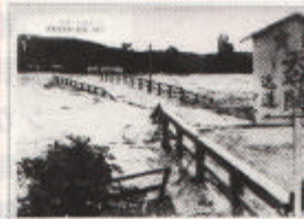
相生橋崩壊の現場(その1)
